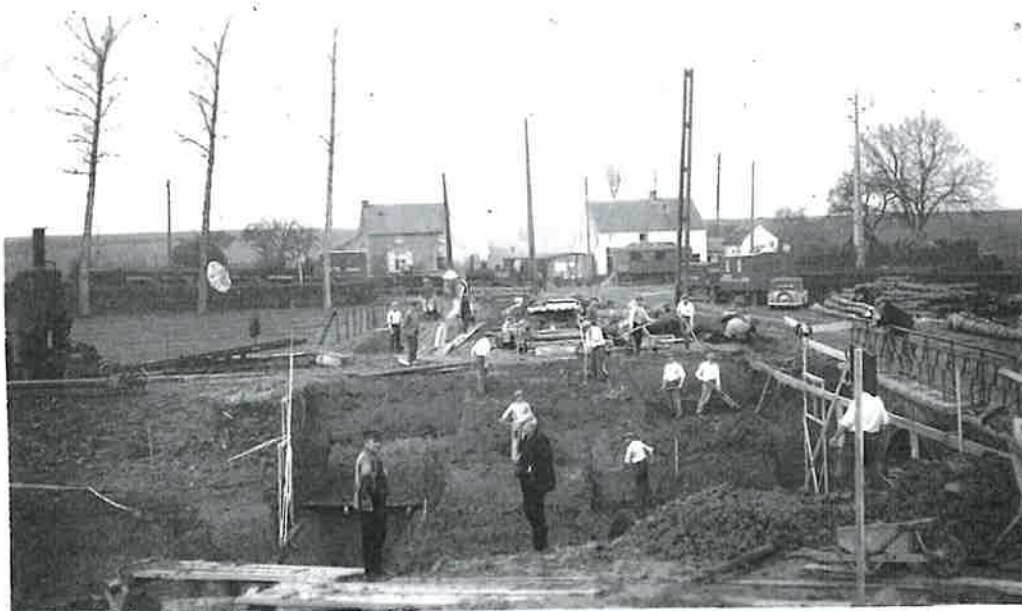
TRAVAUX A L'EMPLACEMENT DU NOUVEAU PONT
