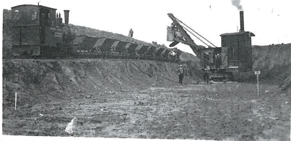
CREUSEMENT DE LA NOUVELLE CHAVEE DE WASSEIGES (1936)
